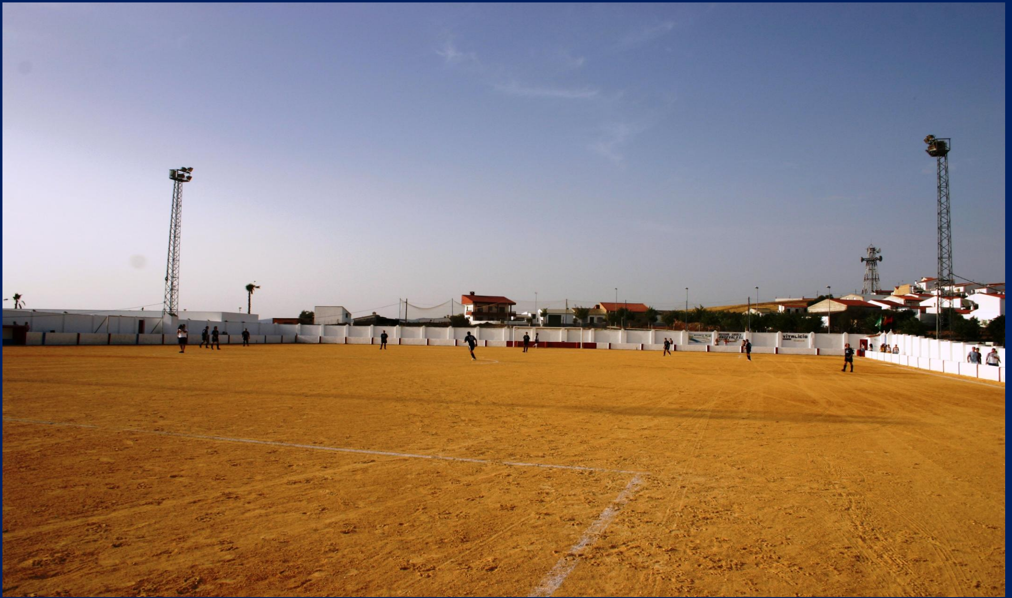
Fig. nº 9.- Terreno de albero y la iluminación eléctrica.
