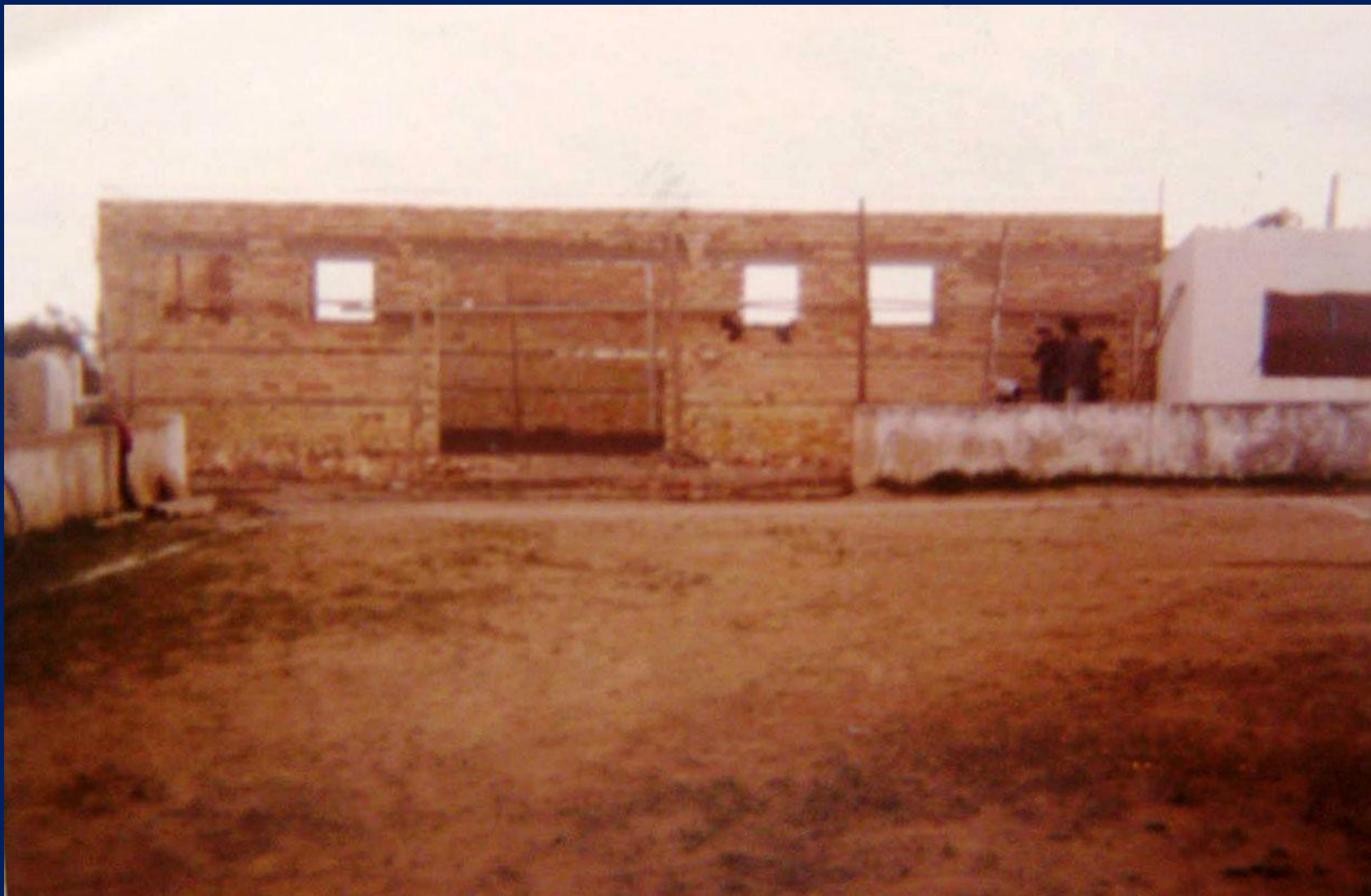
Fig. nº 7.- Construcción de nuevos vestuarios.
