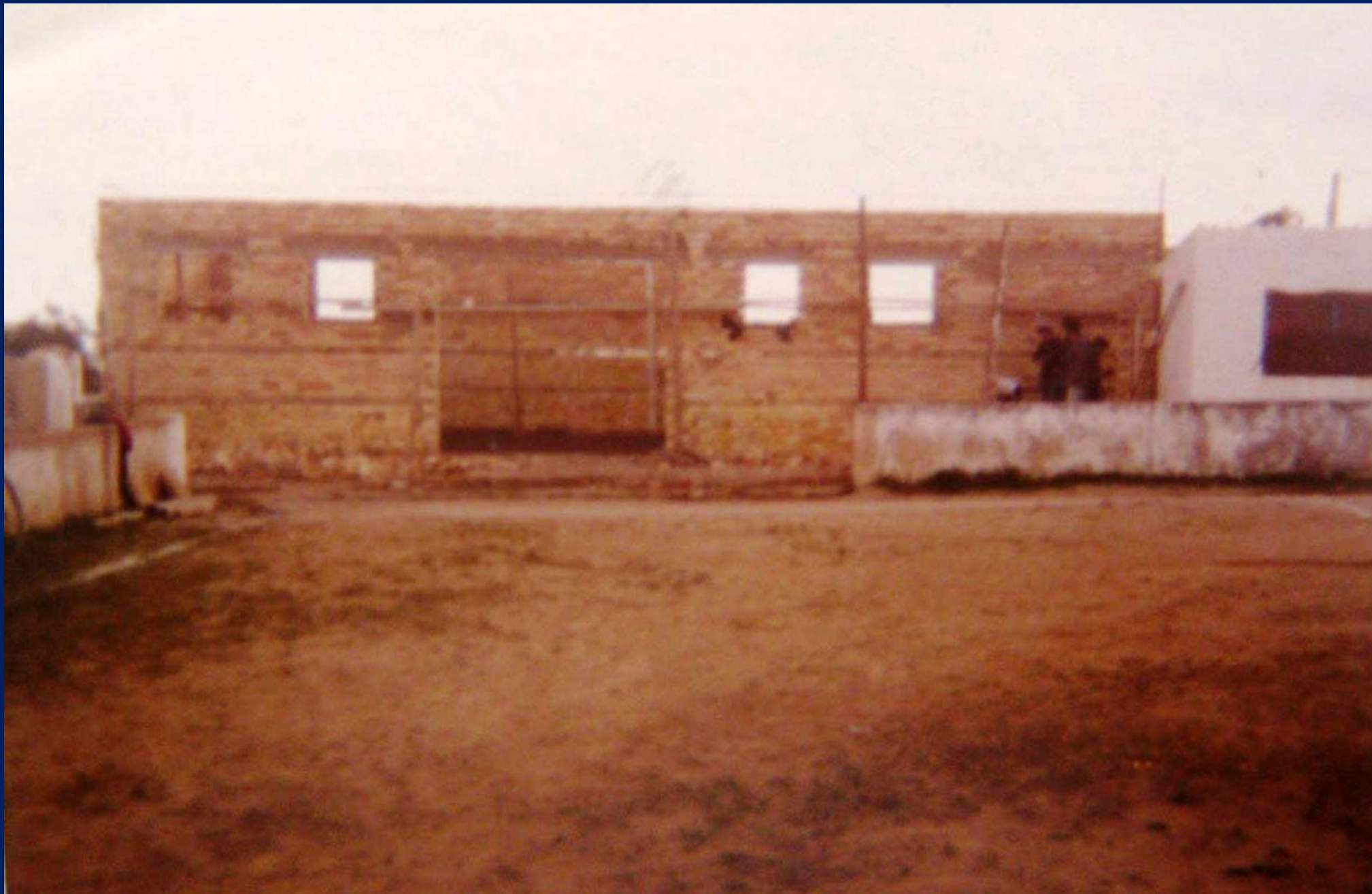
Fig. nº 7.- Construcción de nuevos vestuarios.
